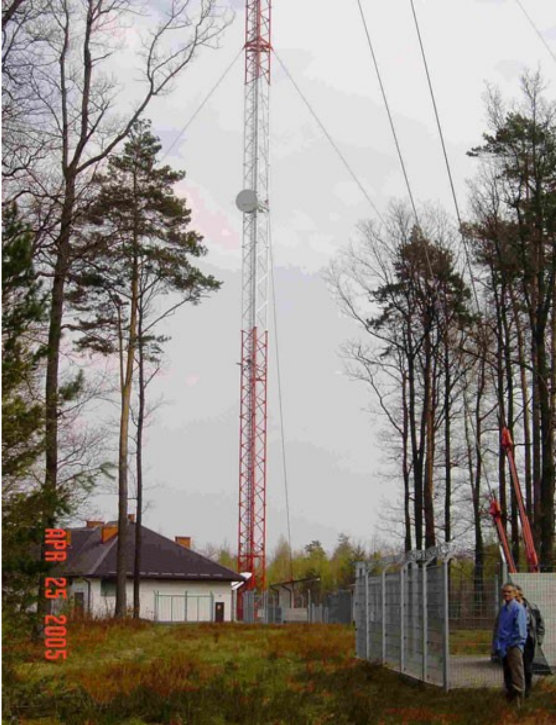
الشكل (2-3) - صورة الصارية المكبلة المدروسة الموجودة بمركز الإذاعة و التلفاز بمدينة Przysucha–Kozłowiec البولندية بارتفاع 182.7م [16]
